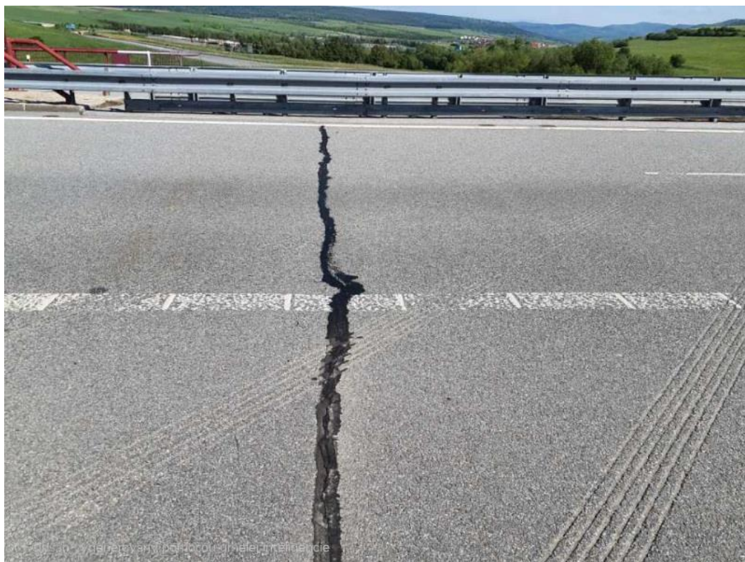
Obrázok 5 – Mrazová trhlina
