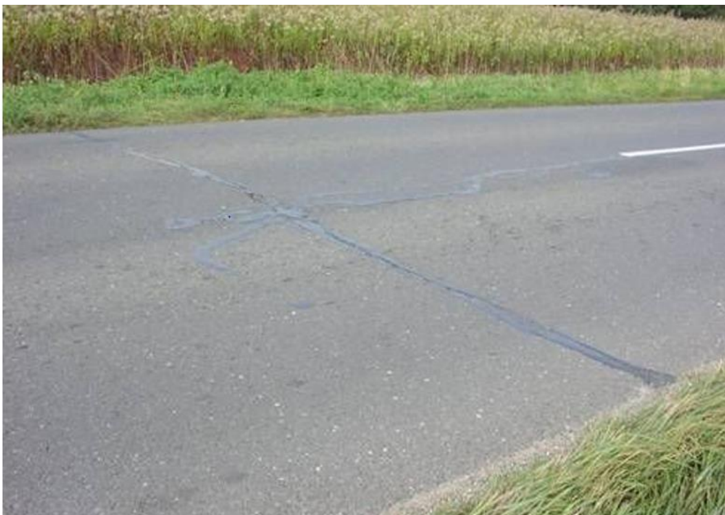
Obrázok 4 – Mrazová trhlina
